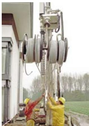
Fig.4: Applicazione di una sonda RAUGEO PE-Xa
