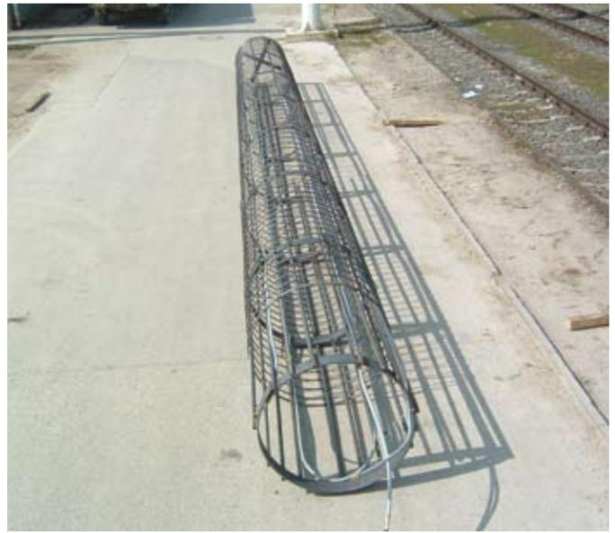
Fig.14: Pilastrò di fondazione con sonde integrate RAUGEO
