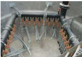
Fig.63: Collettore in materiale polimerico
