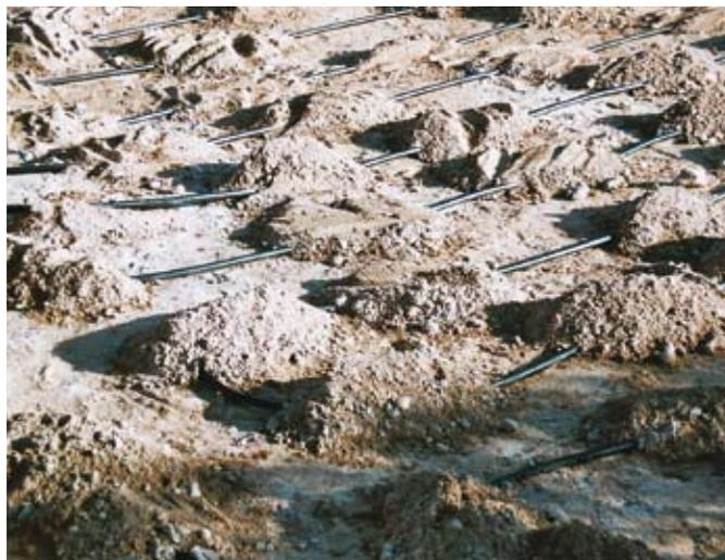
Fig.12: Posa del collettore RAUGEO collect PE 100
