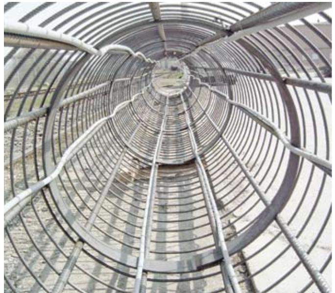
Fig.15: Pilastrò di fondazione con sonde integrate RAUGEO visto dall'interno
