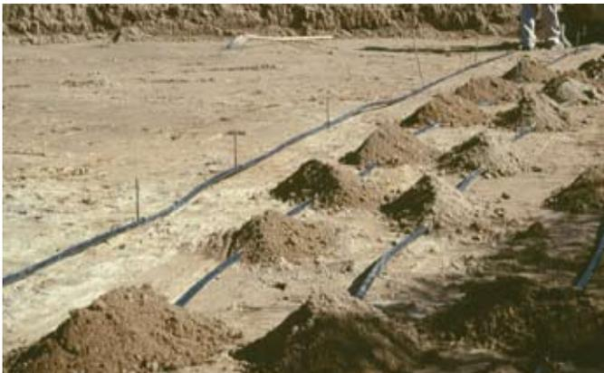
Fig.47: Copertura dei tubi con terra o sabbia
