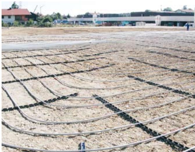
Fig.10: Posa del collettore RAUGEO collect PE-Xa
