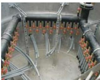
Fig.25: Collettore in materiale polimerico
