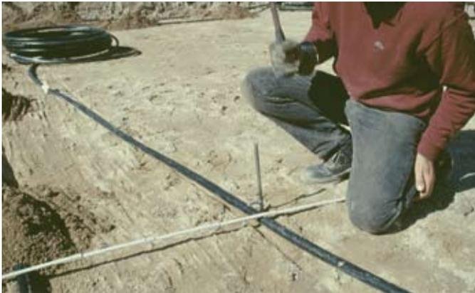
Fig.46: Posa del tubo e fissaggio
