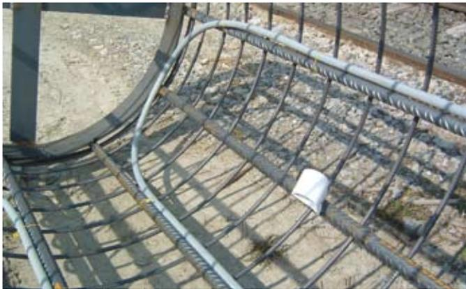
Fig.58: Montaggio dei tubi nell'armatura a gabbia.
