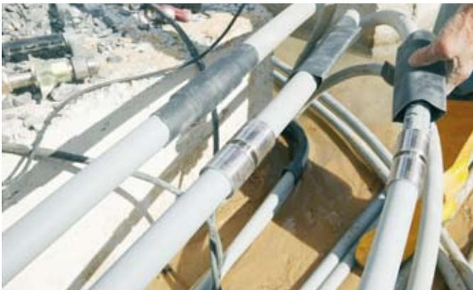
Fig.54: Collegamento ai condotti di raccordo
